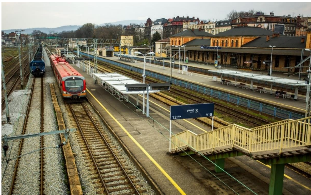
Rysunek 2.9 Obecny dworzec kolejowy Bielsko-Biała Główna wraz ze schodami prowadzącymi na kładkę, która pozwala na przejście piesze na dworzec autobusowy
